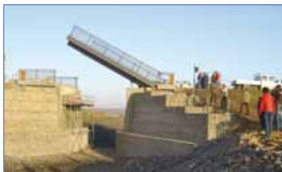
Hubbrücke über den Kanal
