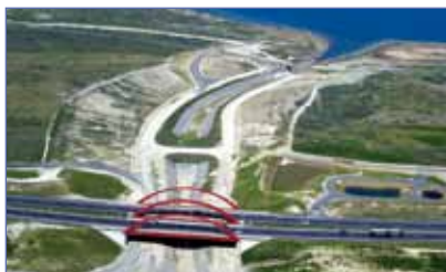
Kanal mit Autobahnbrücke A 38
