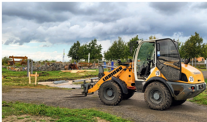
Baubeginn für den neuen Kletterpark: Los ging es Ende September mit dem Tiefbau und Fundamentarbeiten (Foto: unikumarketing / Anett Commichau)
