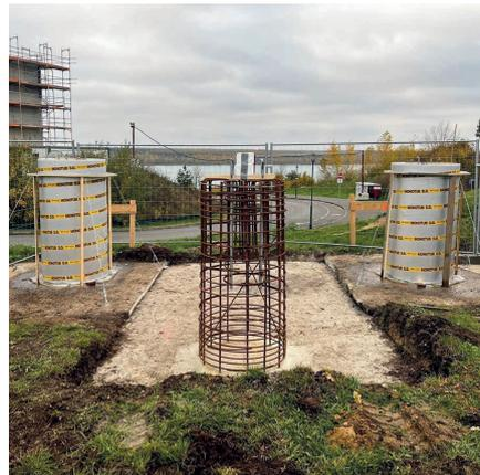
Auch die Sockelfundamente wurden betoniert.
