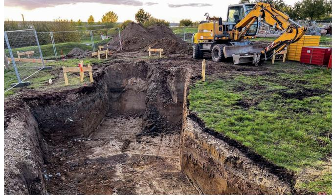
Für die zusätzlichen Stützen der Kletteranlage musste zunächst eine große Menge Erde ausgehoben werden.
