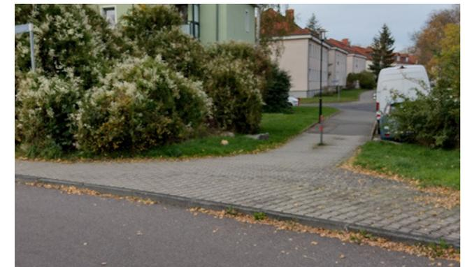
Abb. 77 Verbindung zwischen Am Poseidon und Hohe Straße: Der Bord soll abgesenkt werden.
